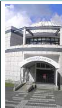
展示物の劣化等の原因により現在は閉館している歴史村内のロボット館
